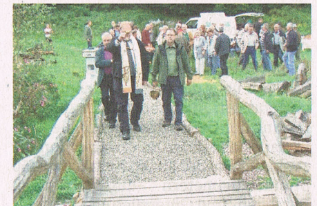
Sanierter: Der Bohlensteg durchs Hafenlohrtal bei Rothenbuch. Foto: Annette Helfmann
