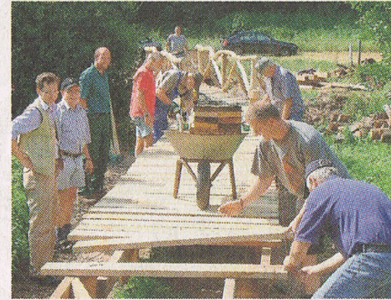
Endspurt im Hafenlohrtal: Die Helfer bei der Instandsetzung des Stegs. Foto: Annette Helfmann
